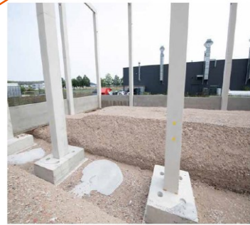
Erd- und Tiefbau
