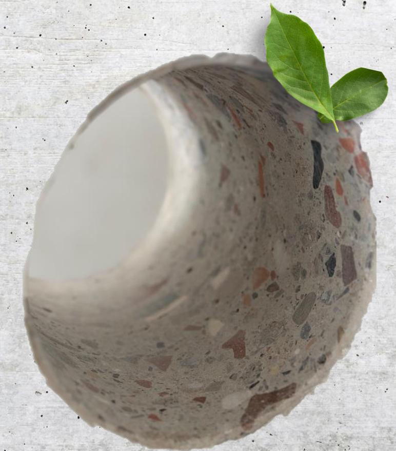
Kernbohrung der Büscher-Wand
