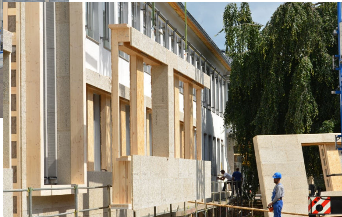
" Plusenergieschule Detmold Gebäude 1 mit innovativen Dämmelementen in Holzbauweise" Foto: Harald Semke © pape oder semke ARCHITEKTURBÜRO
