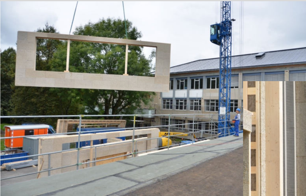
Untertitel: " Plusenergieschule Detmold - heterogene Altbaufassade wird homogen wirtschaftlich angeschlossen" Foto: Harald Semke © pape oder semke ARCHITEKTURBÜRO
